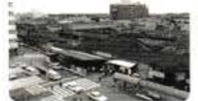
1985年頃、解体前の茅ヶ崎駅 提供：茅ヶ崎市
