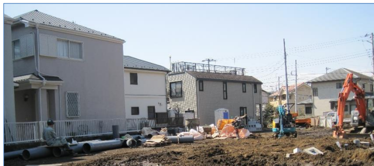
24街区 土地造成の現場
