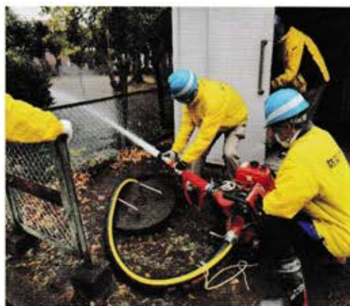
エンジンポンプ性能確認
